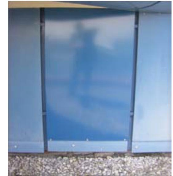
Bild 21: Detailaufnahme Metallfassade blau pulverbeschichtet mit Reinigungsmusterfläche
