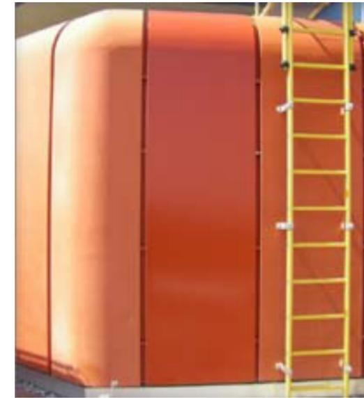
Bild 20: Metallfassade pulverbeschichtet, 15 Jahre nicht gereinigt mit Reinigungsmusterfläche
